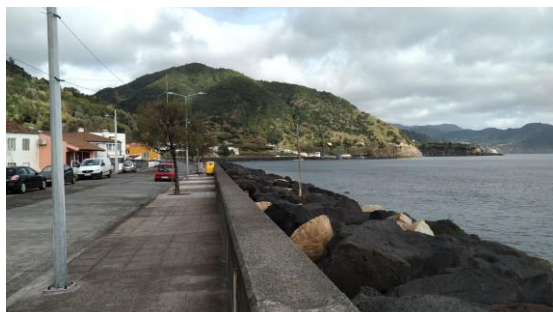
Obra longitudinal aderente com manto resistente em enrocamento – Ribeira Quente, Povoação
