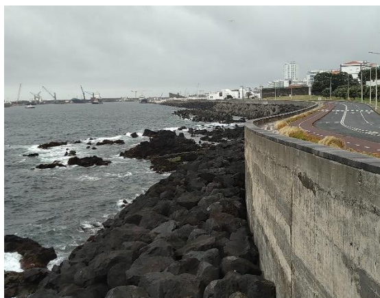
Muro longitudinal vertical - Frente Urbana da Calheta.
