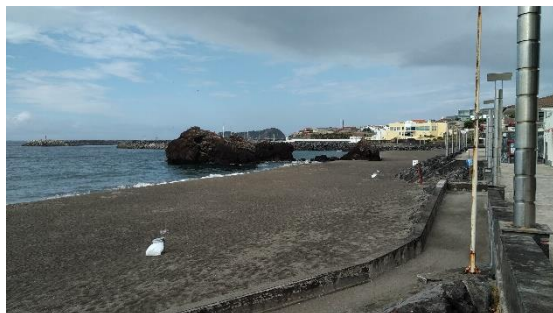
Obra longitudinal aderente com manto resistente em enrocamento – Praia da Vinha da Areia, Vila Franca do Campo.
