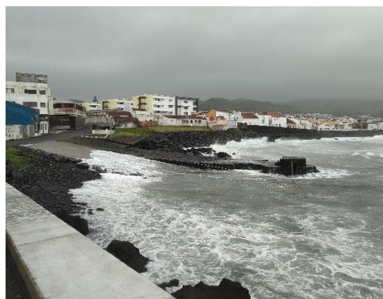
Obra aderente com manto resistente em enrocamento – Frente urbana Rosário
