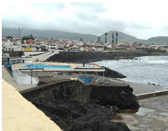
Obra longitudinal aderente com manto resistente em enrocamento – Ribeira Grande.
