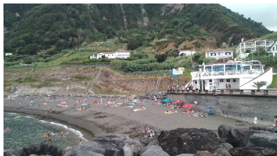
Muro de paramento vertical em betão e berma de proteção em enrocamento – Ribeira Quente, Povoação
