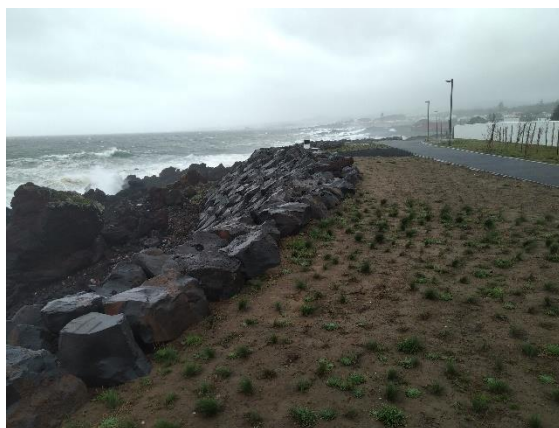
Setor com Enrocamento de suporte ao passeio marítimo e ciclovia de Lagoa Berma de proteção em enrocamento Atalhada
