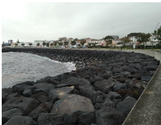
Obra longitudinal aderente com manto resistente em enrocamento ou tetrápodes – Avenida do Mar, Ponta Delgada
