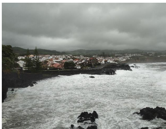
Obra aderente com manto resistente em enrocamento – Frente urbana Santa Cruz
