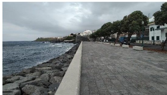
Obra longitudinal aderente com manto resistente em enrocamento – Frente urbana de Vila Franca do Campo.
