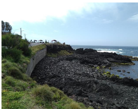
Muro de paramento vertical em betão – Mosteiros, Ponta Delgada
