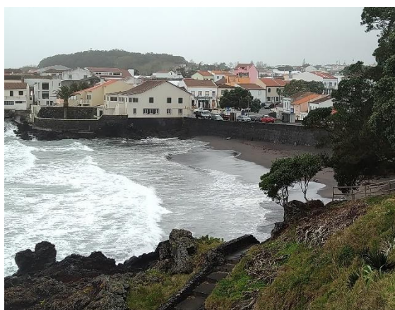
Muro de paramento vertical em Alvenaria – S. Roque, Ponta Delgada
