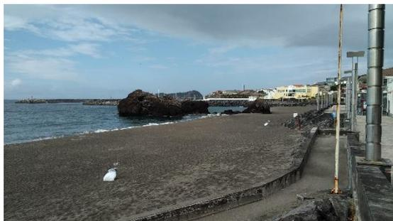
Obra longitudinal aderente com manto resistente em enrocamento – Praia da Vinha da Areia, Vila Franca do Campo.
